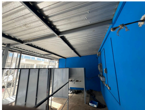
Mantenimiento al laboratorio de Mecánica y Soldadura.
