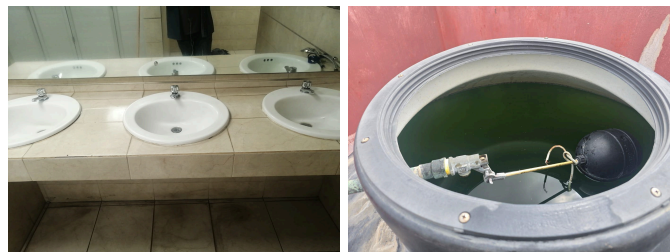
Reparación de lavamanos y fallas hidráulicas.
