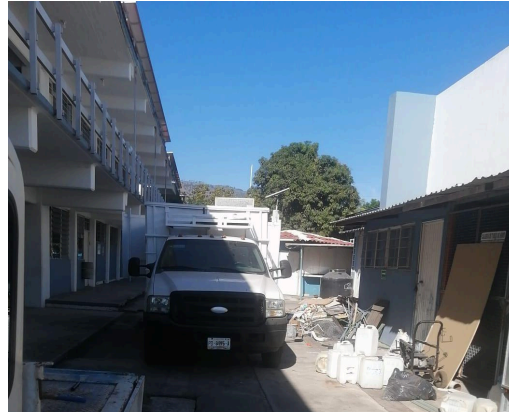
Eliminación de chatarra y escombros.
